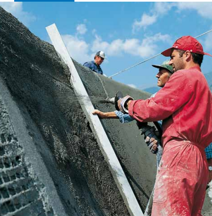
Applicazione di Mapegrout T40 con macchina intonacatrice
