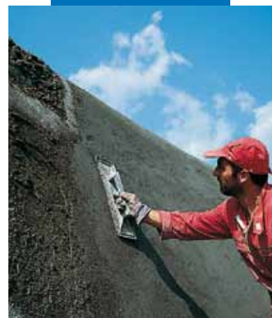
Rifinitura del Mapegrout T40 a frattazzo
