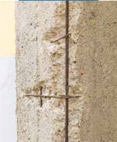
Preparazione del supporto
