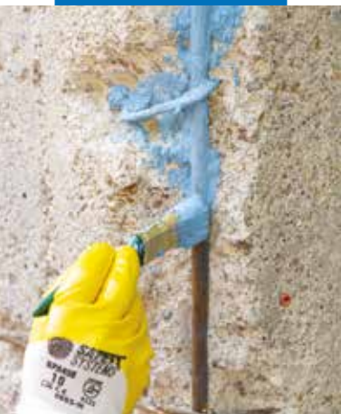
Passivazione dei ferri di armatura con Mapefer 1K
