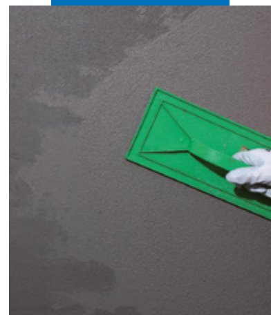
Frattazzatura di Mapegrout 430
