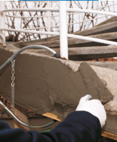
Applicazione a cazzuola di Mapegrout 430
