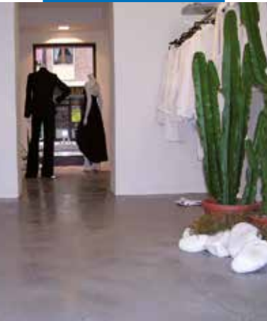
Realizzazione di pavimentazione con Mapecolor Decor 700
