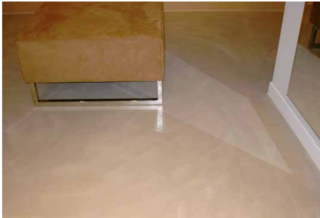
Pavimentazione realizzata con Mapecolor Decor 700
