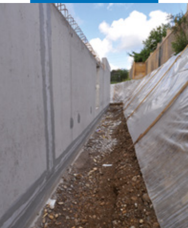
Sigillatura di giunti strutturali su muri controterra
