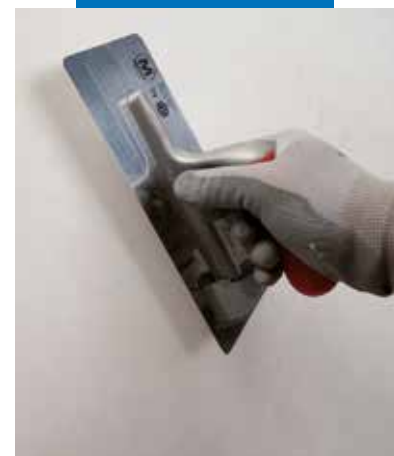
Stesura di un secondo strato di Mape-Antique FC Ultrafine
