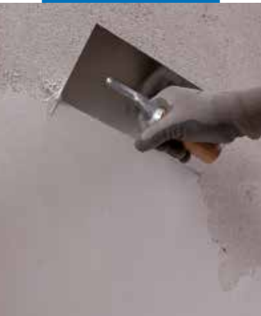
Stesura di un primo strato di Mape-Antique FC Ultrafine
