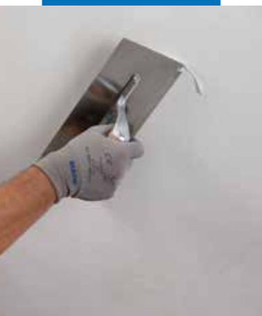
Particolare della fase applicativa di Mape-Antique FC Ultrafine
