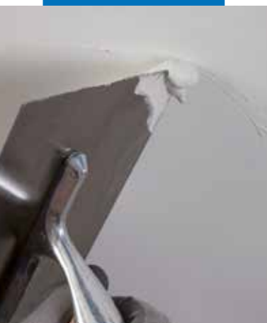
Lisciatura del prodotto con spatola metallica piana
